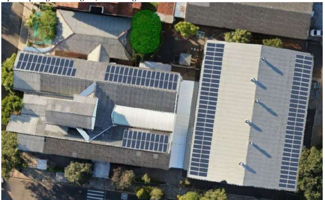
Figura 3: Distribuição dos módulos fotovoltaicos sobre os telhados da escola 25 de Julho.
