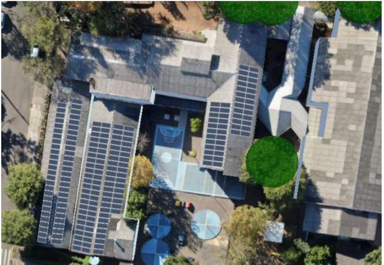
Figura 1: Distribuição dos módulos fotovoltaicos sobre os telhados da escola Ildo Meneguetti.
