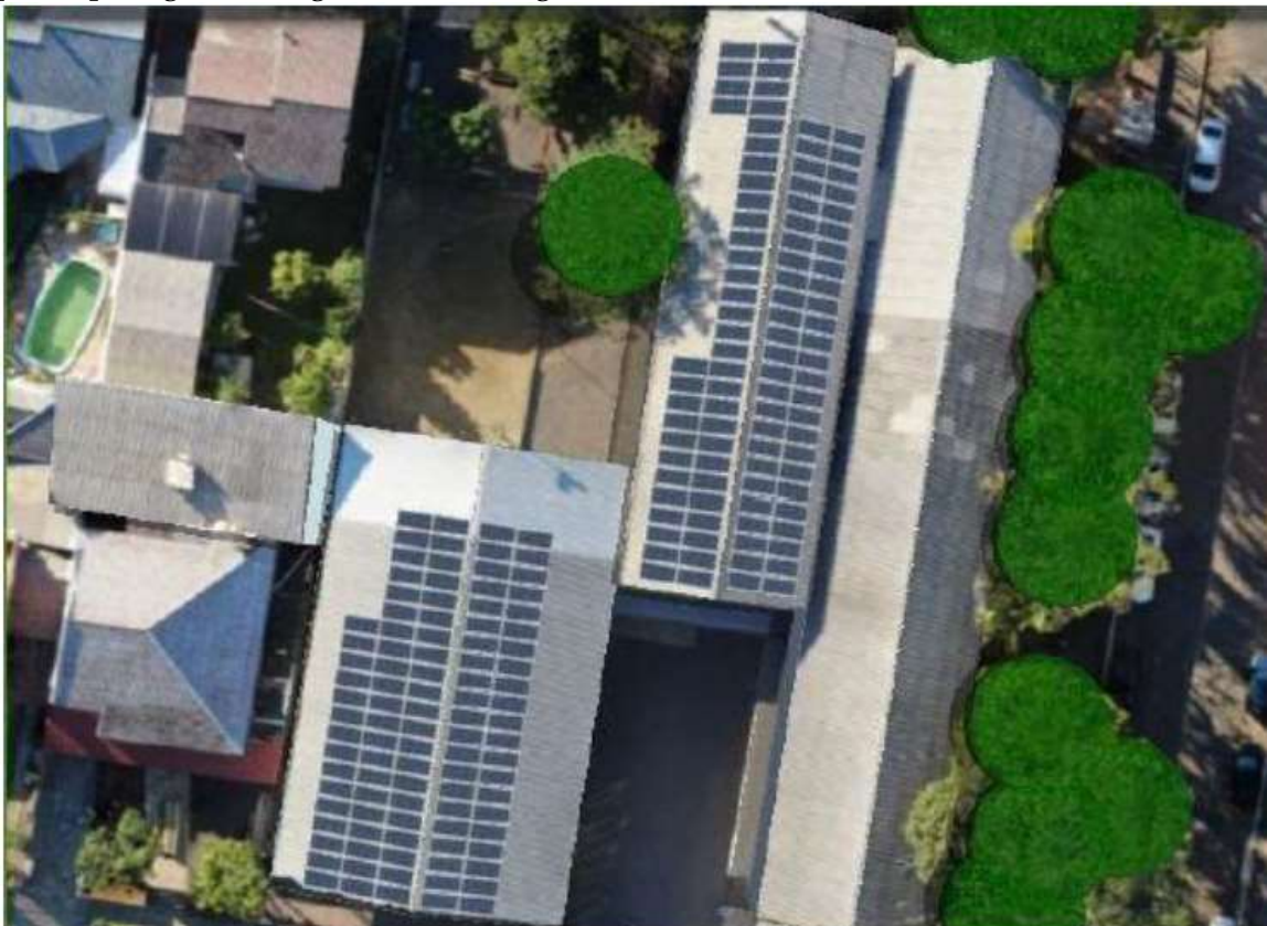
Figura 5: Distribuição dos módulos fotovoltaicos sobre os telhados da escola Jardim Panorâmico.
